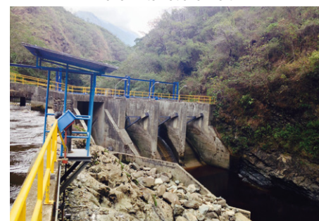
Central Hidroeléctrica Patico
