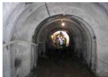
Infraestructura: Túneles de Fortuna
