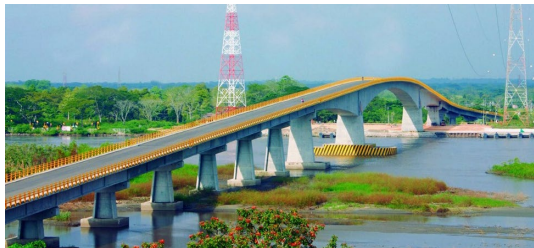
► GUILLERMO GAVIRIA CORREA BRIDGE Barrancabermeja, Santander
