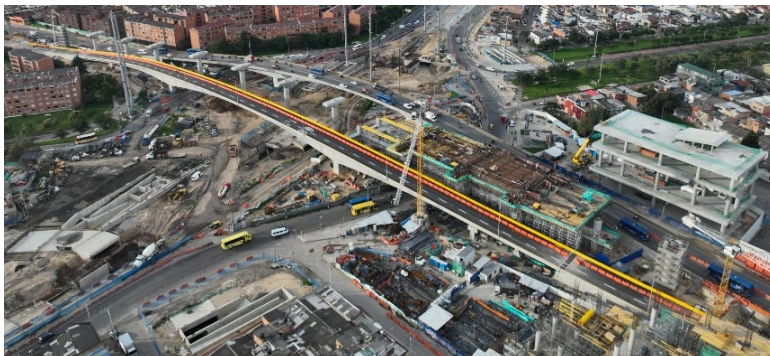
Puentes Av. Primera de Mayo - Bogotá, Cundinamarca
