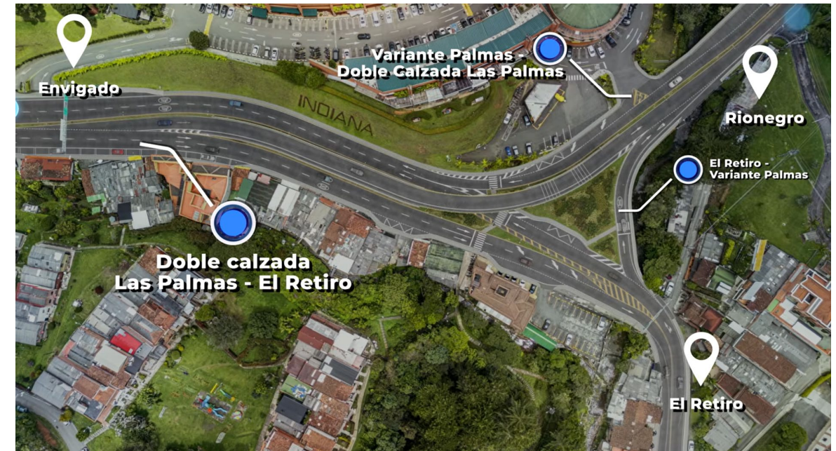
Imagen ilustrativa Intercambio Vial Las Palmas – Antioquia Foto tomada de Obras Antioquia
