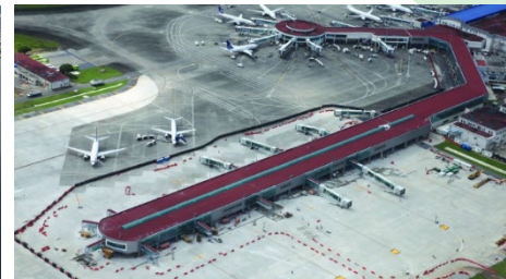
▶ EL AEROPUERTO INTERNACIONAL DE TOCUMEN Panama City, Panama
