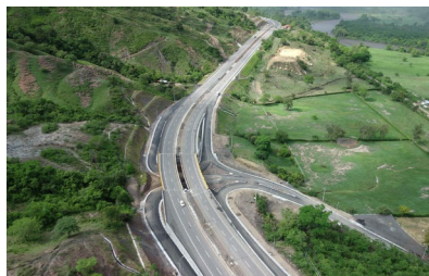
▶ RUTA DEL SOL SECTOR I (TRAMOS II Y III) Guaduas, Cundinamarca
