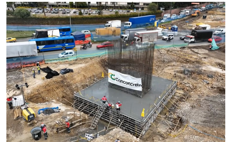
Hincada de pilotes proyecto Calle 13
