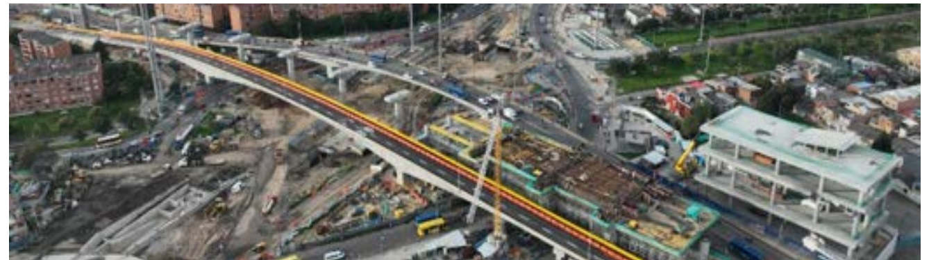
Puentes Av. Primera de Mayo - Bogotá, Cundinamarca
