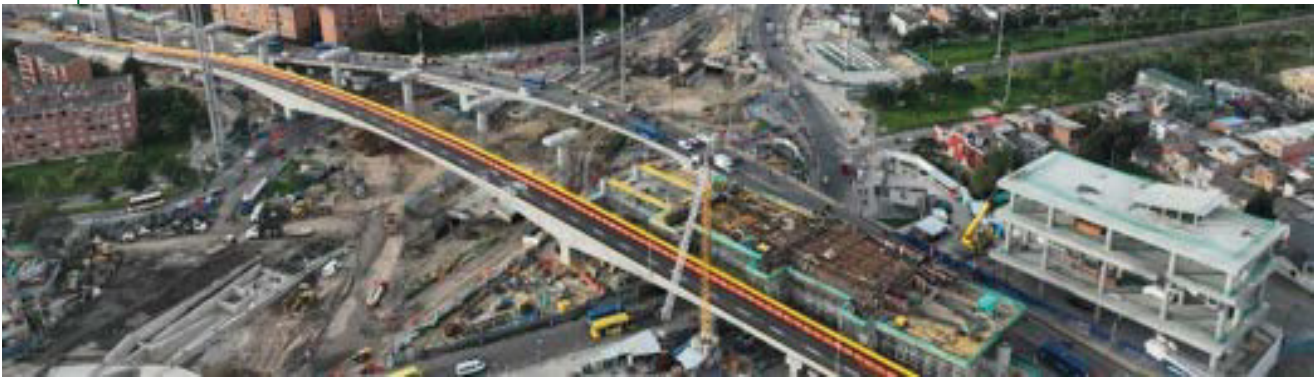
Bridges on Primera de Mayo Avenue—Bogotá, Cundinamarca
