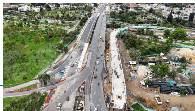
Apertura del Puente Occidental de la Av. 68 ▶ Grupo 5 Av. 68 – Bogotá, Cundinamarca
