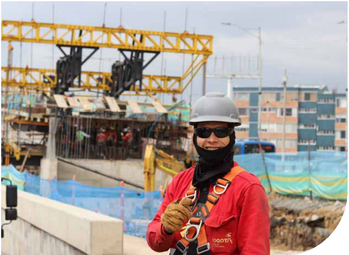
▲ José Alfredo Torres, contractor of GMG Construcciones.
