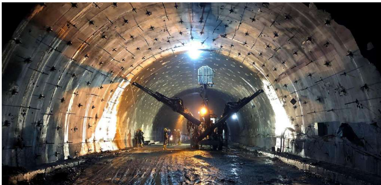
Completion of the La Línea Tunnel,, Calarcá, Quindío – Cajamarca, Tolima
