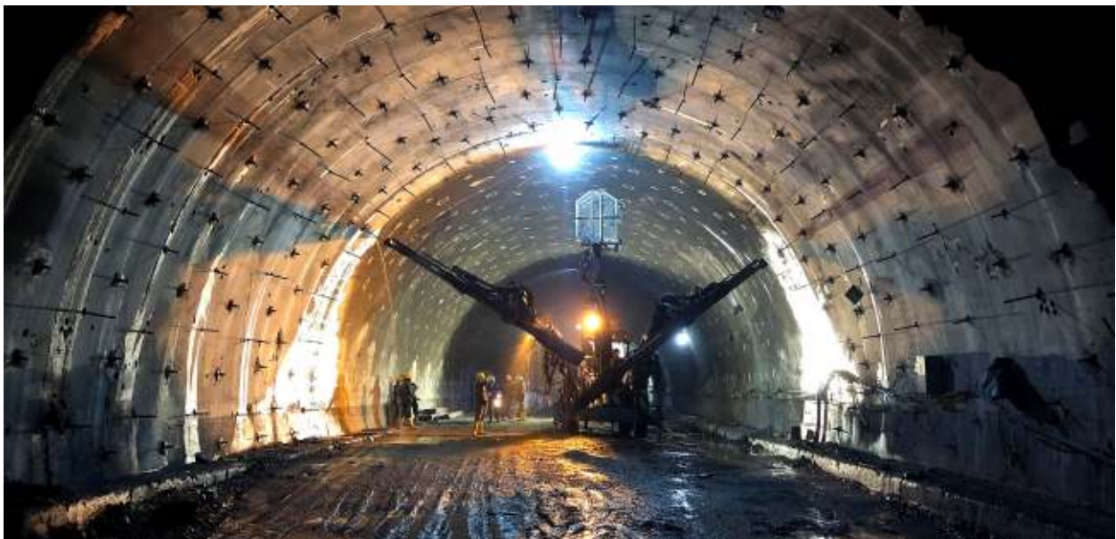
Terminación túnel de La Línea, Calarcá, Quindío - Cajamarca, Tolima.
