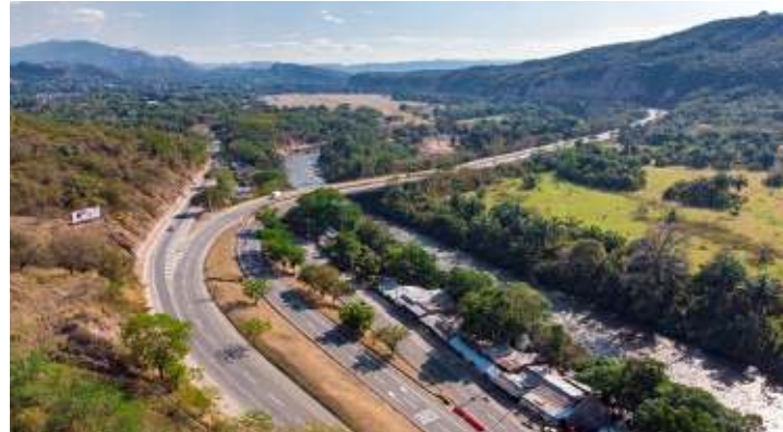
The Bogotá - Girardot, Cundinamarca, Vía 40 Express Concession
