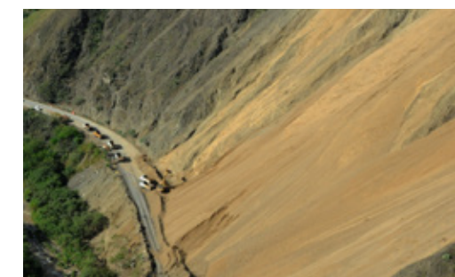
Vía Loboguerrero-Mediacanoa, sector la Balastera, carretera que estuvo cerrada por derrumbes de roca y tierra.
