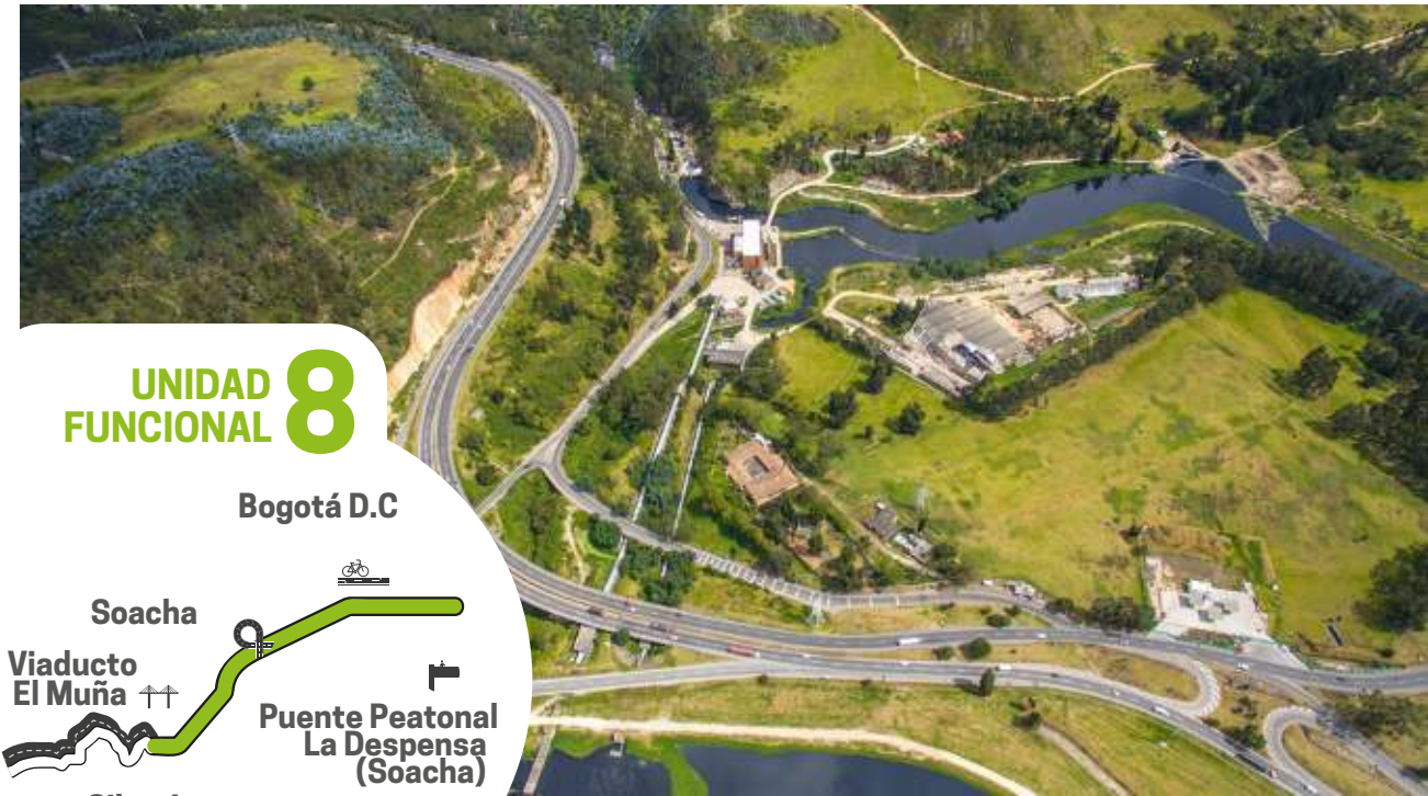
Viaducto el Muña, Bogotá Girardot
