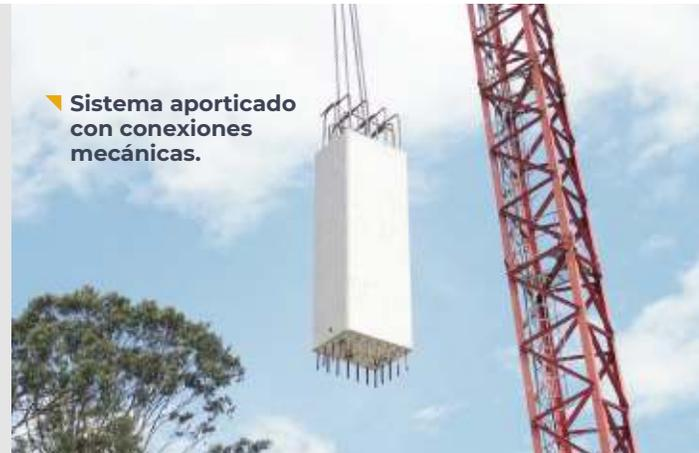
› Sistema aporticado con conexiones mecánicas.
