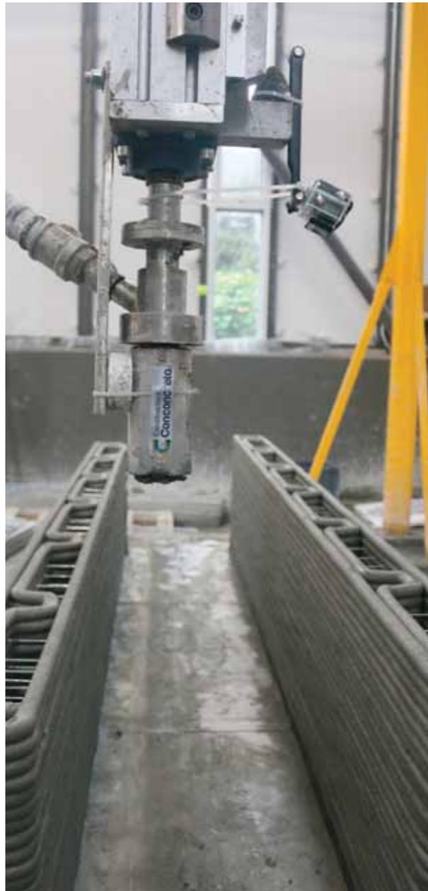
Impresión de muros para prototipo de vivienda.
