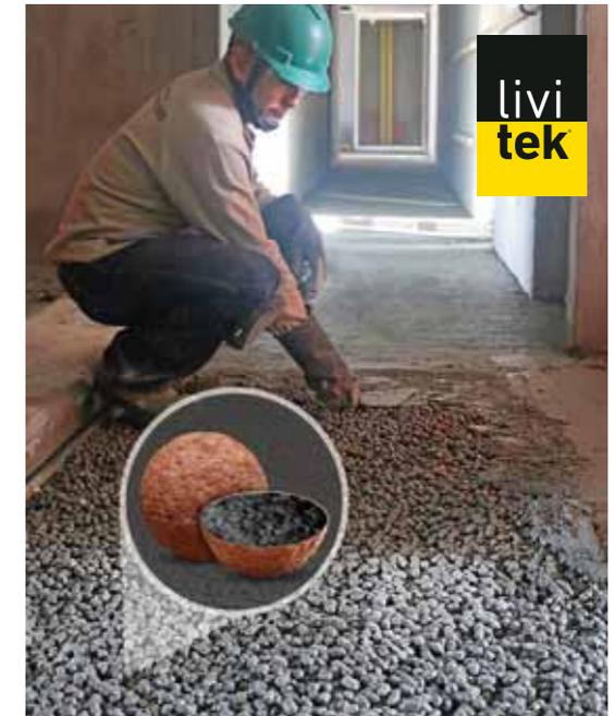
Livitek mezclado con concreto para mortero de nivelación de pisos.
