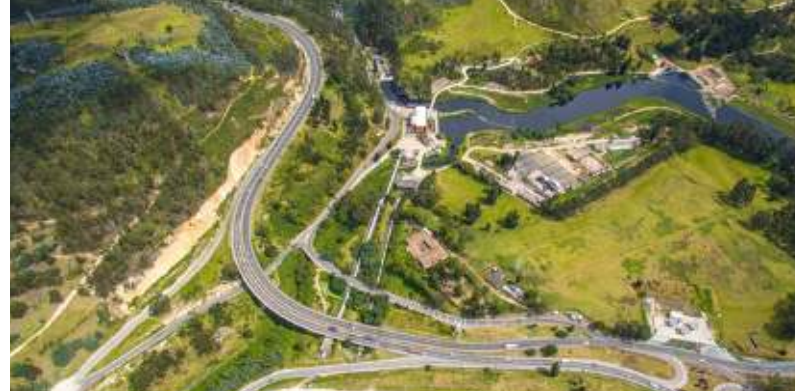
Viaducto el Muña, Bogotá Girardot
