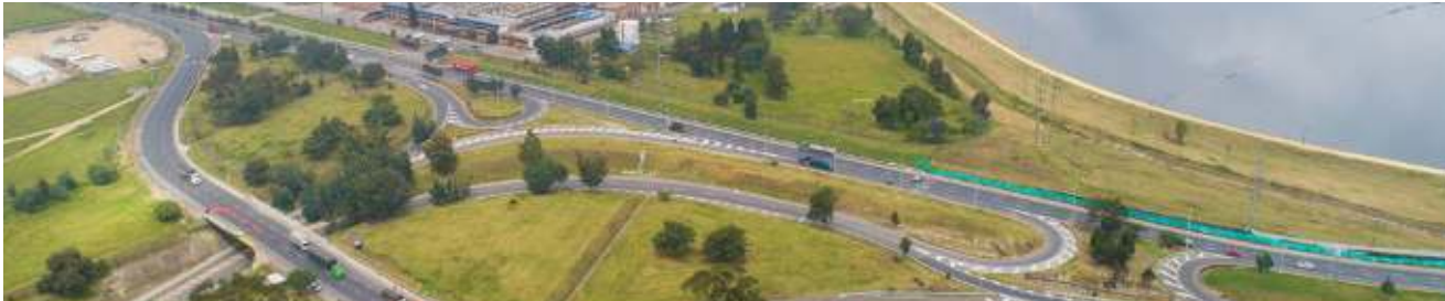
Viaducto el Muña, Bogotá Girardot
