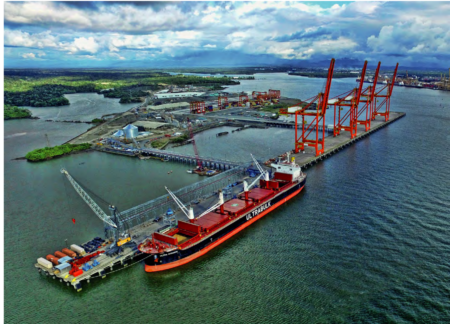
▲ Diseñamos y construimos el muelle de pasarela del Puerto Industrial Aguadulce SPIA. Buenaventura, Valle del Cauca (Colombia).
