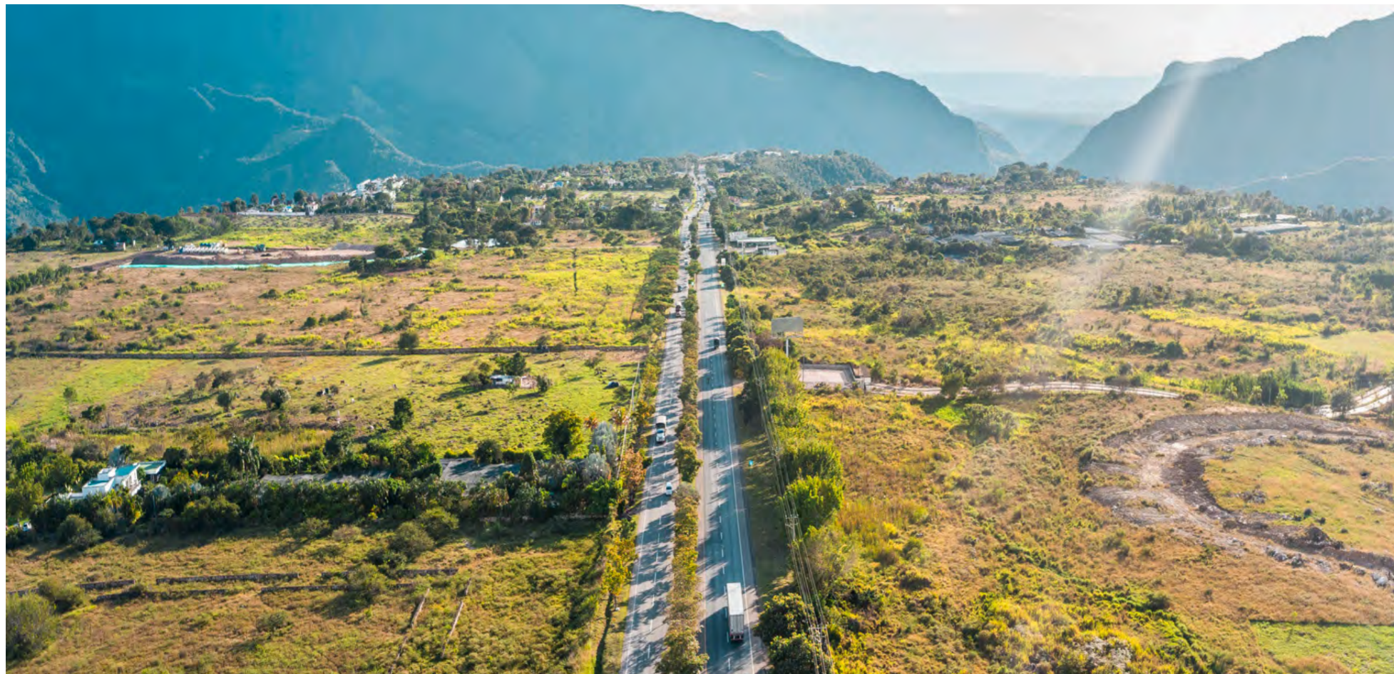
▲ Vía 40 Express. Tercer carril Bogotá-Girardot.
