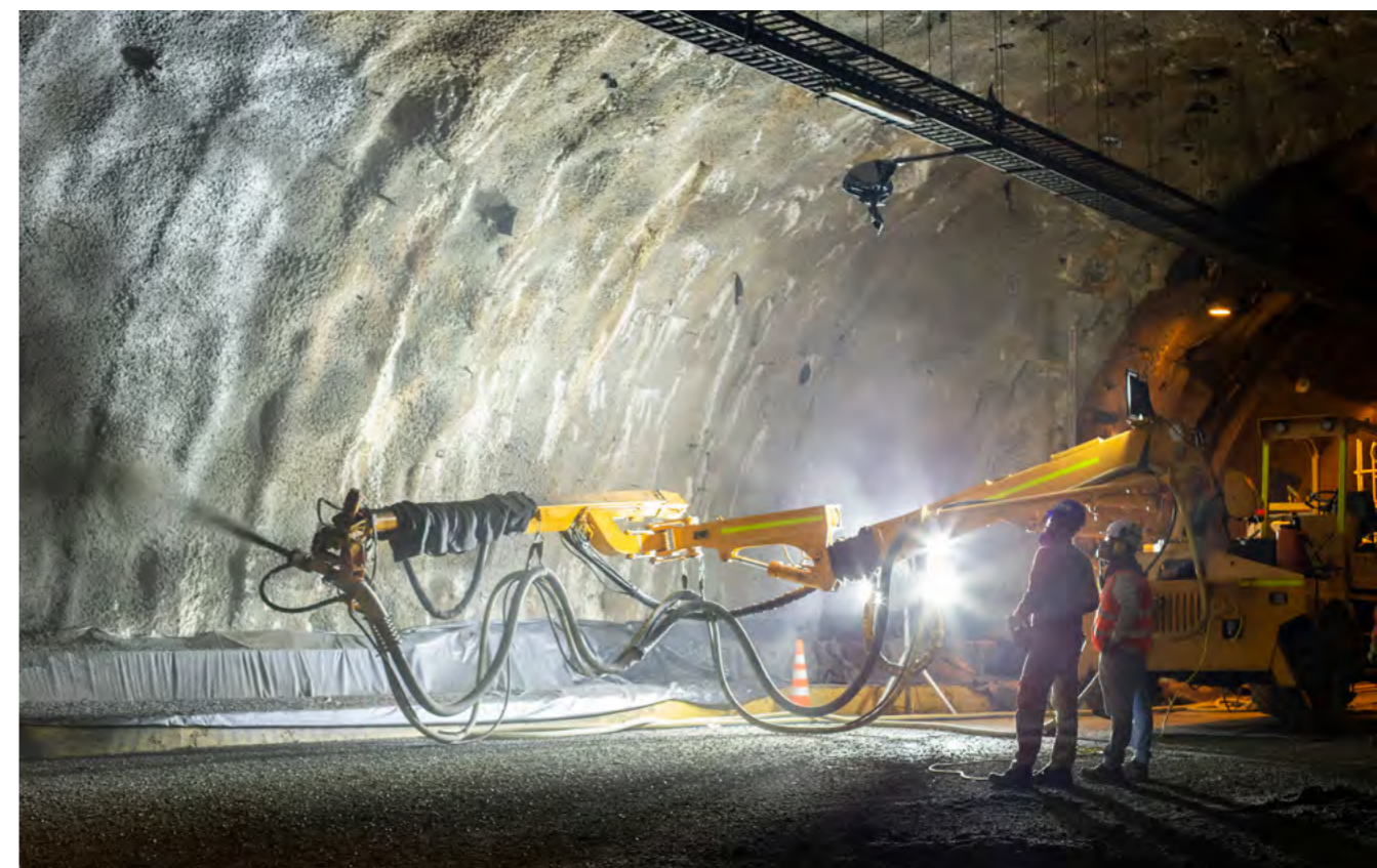
▲ Vía 40 Express. Tercer carril Bogotá-Girardot.
