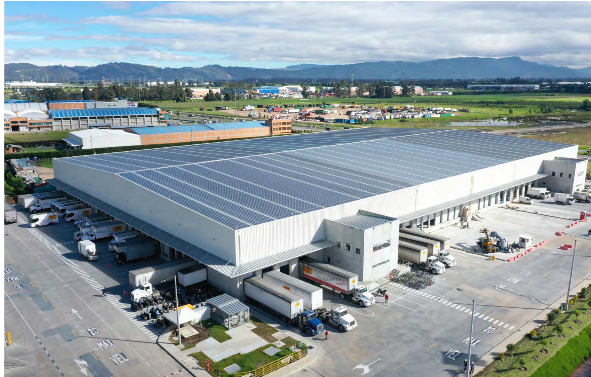
▲ Culminamos la adecuación de las bodegas 3 y 4 en el Parque Industrial Lógica Siberia (Cundinamarca).
