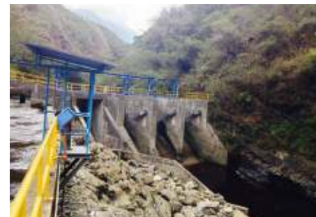
Central Hidroeléctrica Patico
