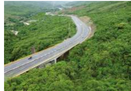
Ruta del Sol sector I (Tramos II y III)
