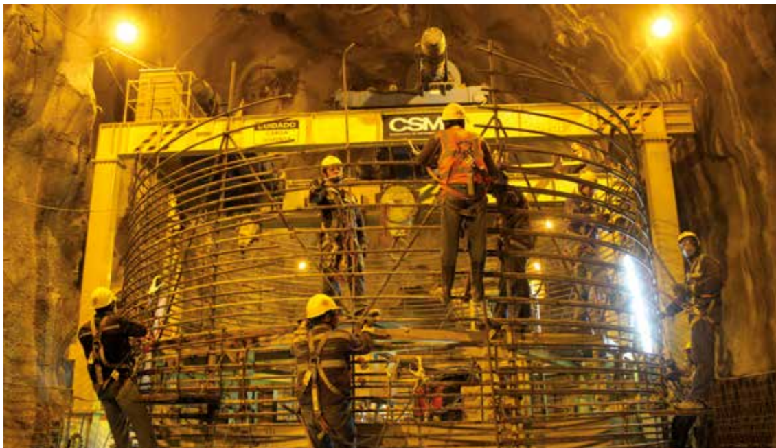
Sistema mecánico de moldeamiento, aplicación e instalación de acero de refuerzo. Hidroituango, Antioquia. Foto: Mateo Herrera P., comunicador Consorcio CCC.
