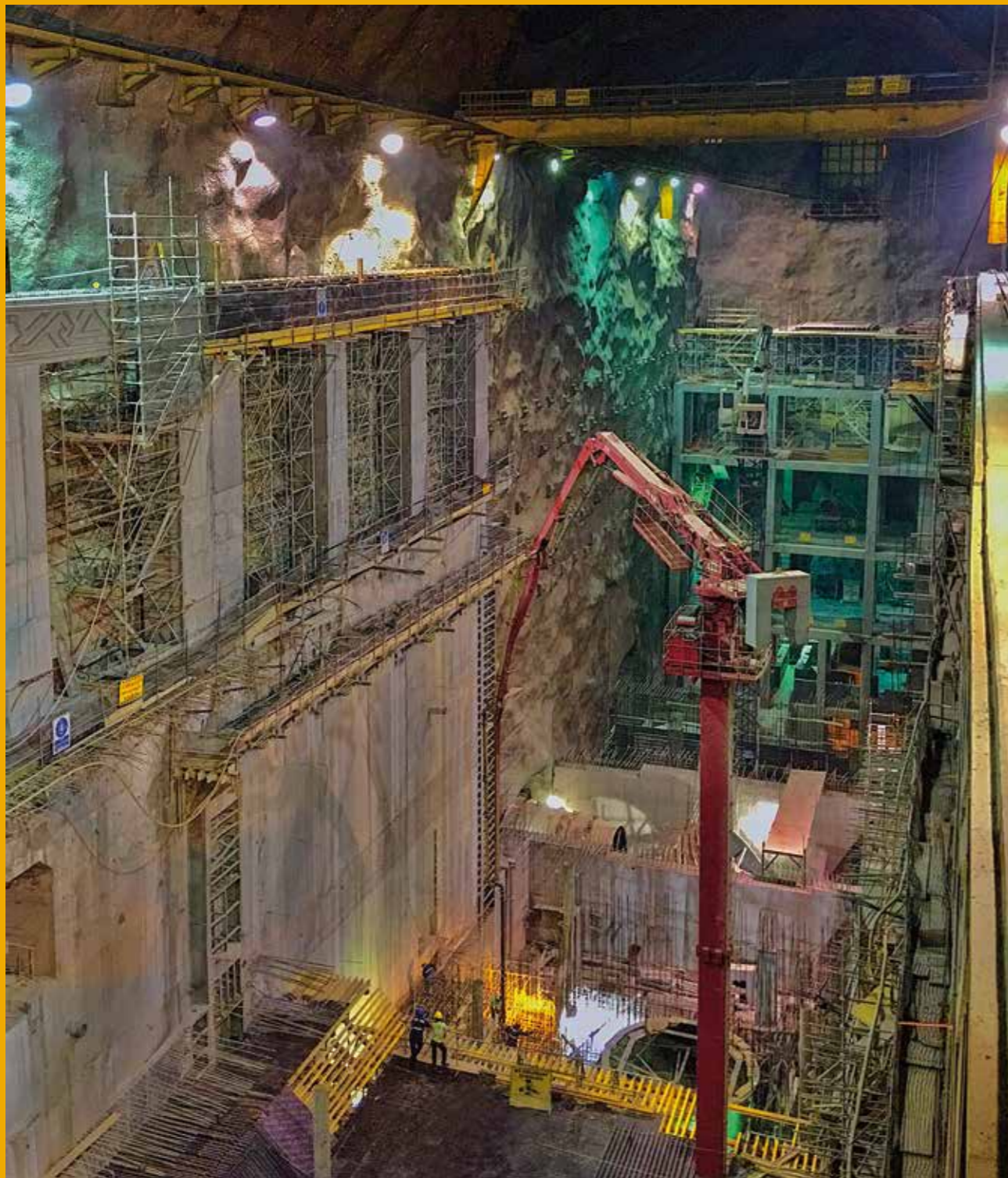
Caverna de máquinas, Hidroituango, Antioquia. Foto: Alejandro Díaz Castrillón, ingeniero junior ganador de la cuarta edición de Con Cámara en Mano.
