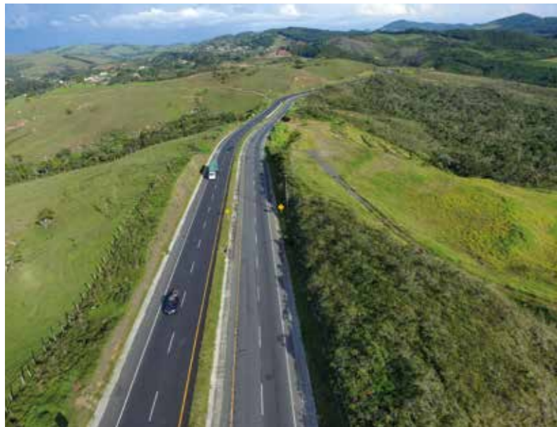
Concesión Vía Pacífico. Vía Buga-Buenaventura.
