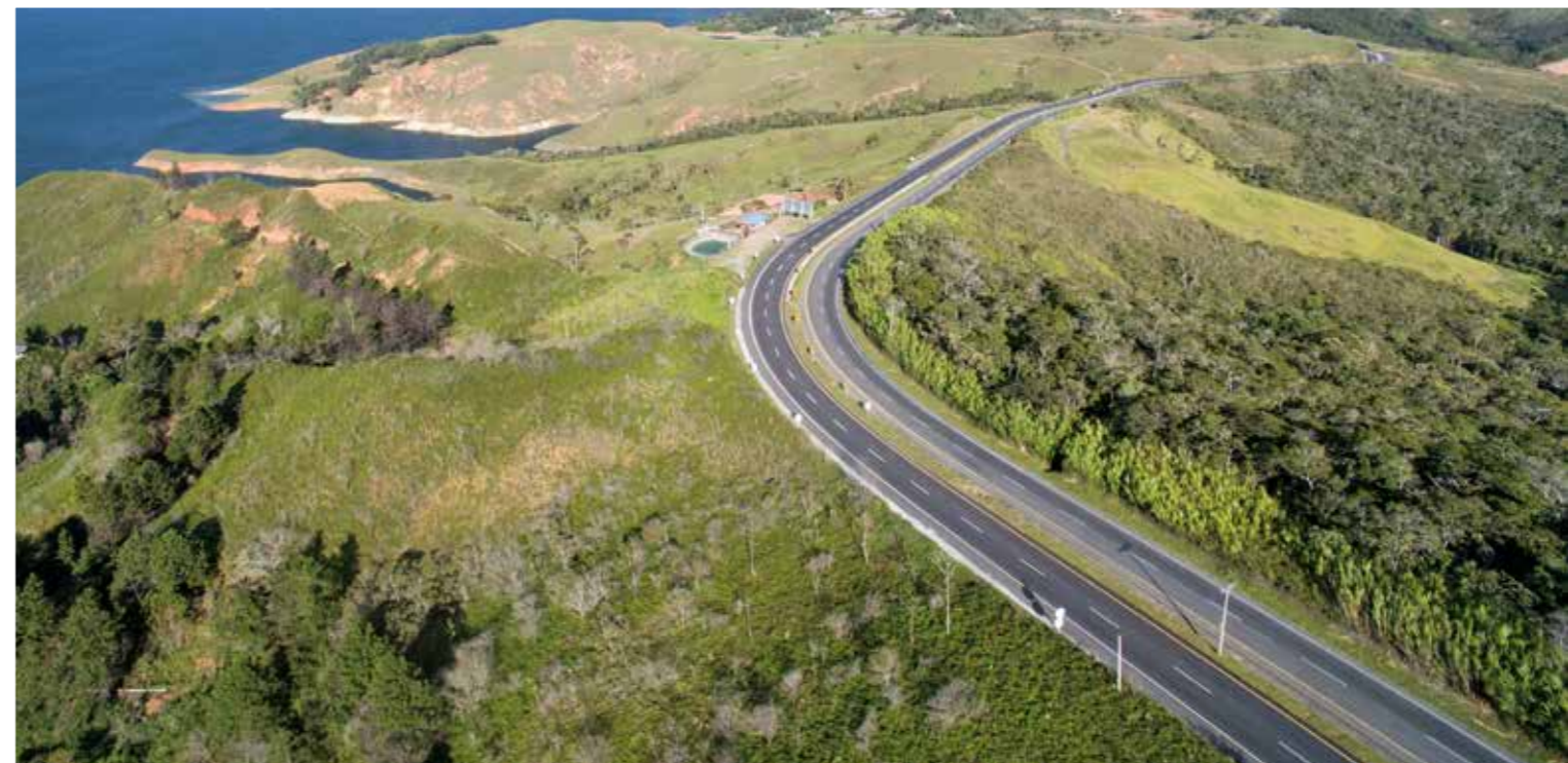
Sector Loboquerrero-Buga, Valle del Cauca.
