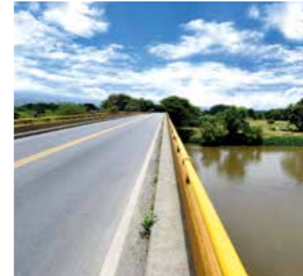
Puente Aguacate, Buenaventura, Valle del Cauca.
