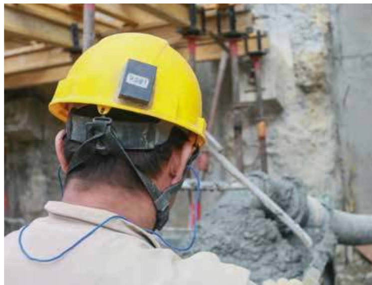
Dispositivo para medición de productividad en obra.
