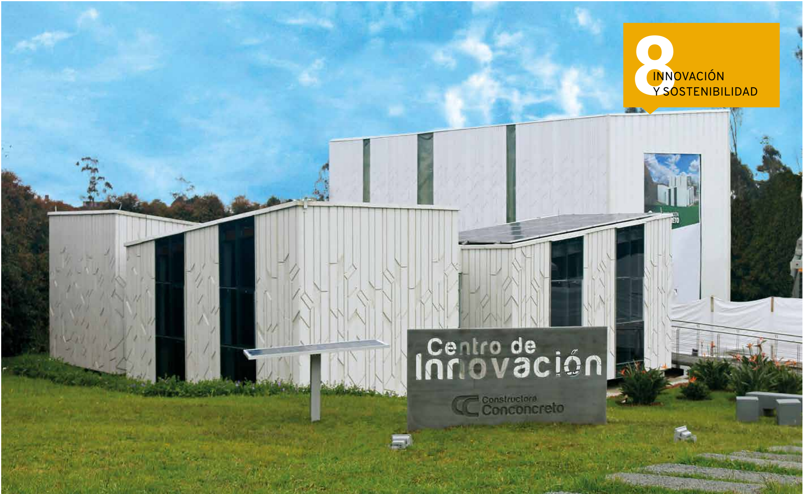
Ampliación Centro de Innovación Concreto. Universidad EIA, Envigado, Antioquia.
