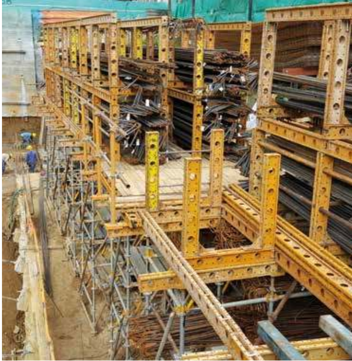
Almacenamiento de acero sobre plataforma en ladera, Cámara de Comercio de Medellín, Centro Empresarial El Poblado.
