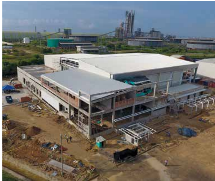
Área construida: 6.416 m 2 Cartagena, Bolívar.
