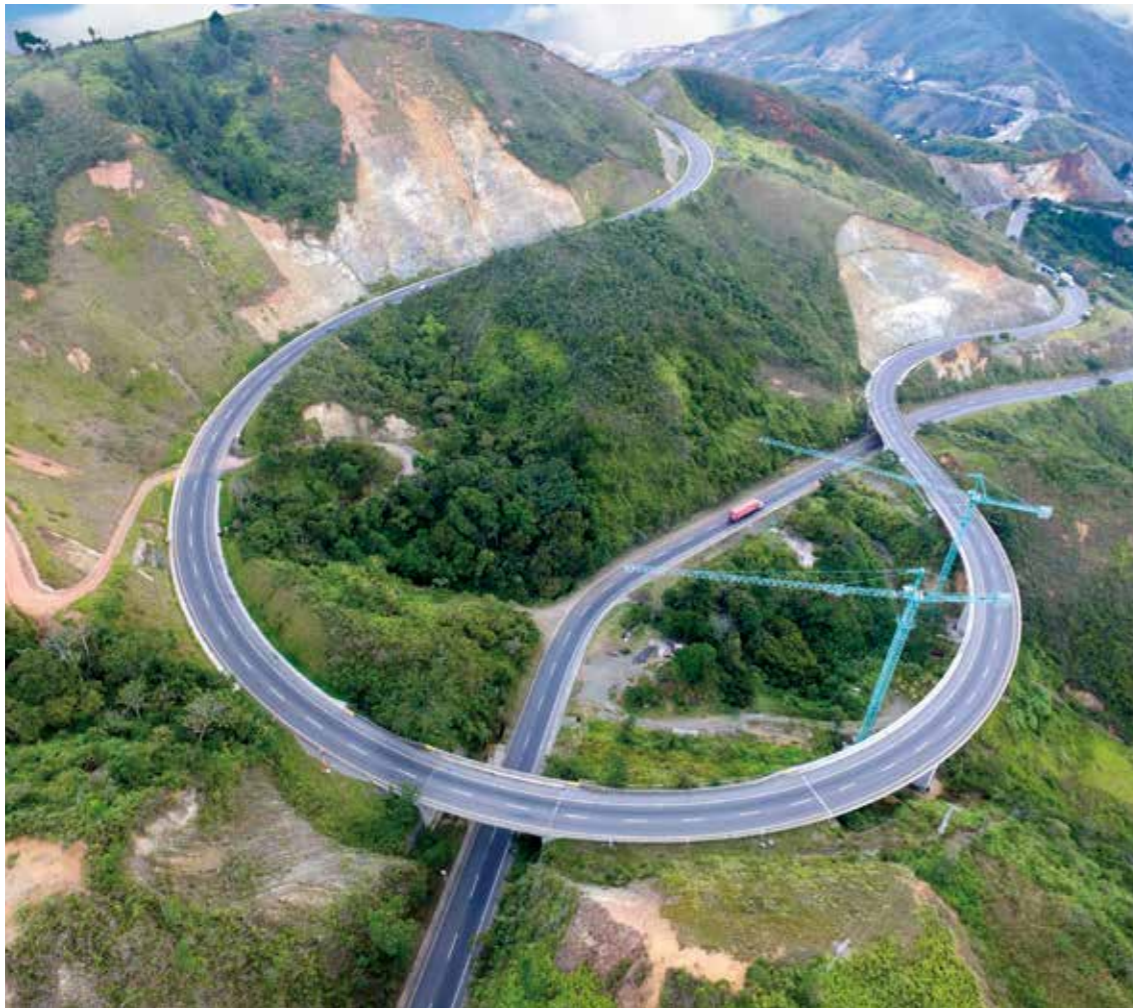
Vía Buga-Buenaventura. Concesión Vía Pacífico.
