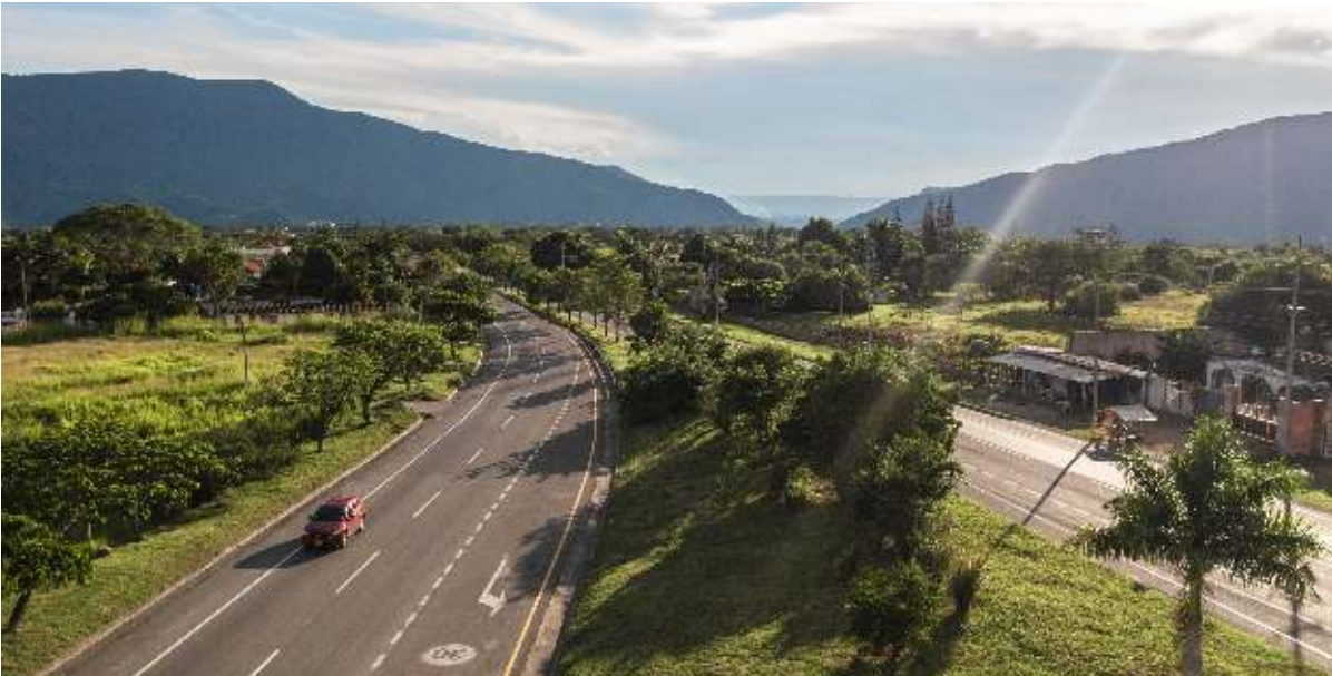
Concesión Vía 40 Express - Bogotá- Girardot, Cundinamarca
