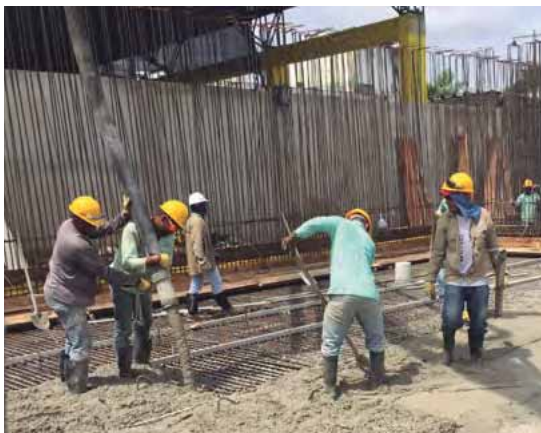
Figura 11.35. Colocación del concreto con manguera o “Trompa de elefante”
