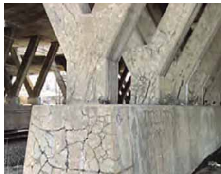
Figura 3.20. Manifestación de la reacción álcalis-sílice (3.11)
