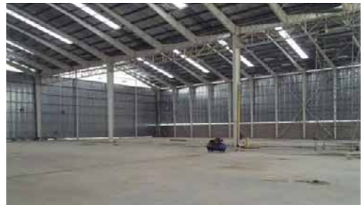
Figura 6.4. Piso de baja contracción. Bodegas Girardota, con uso de Fortacret 10 de Corona ®
