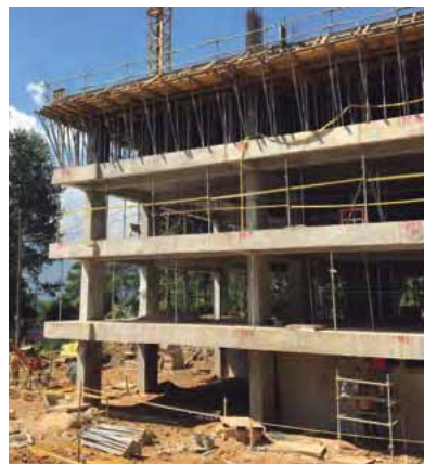
Figura 1.4. Construcción de una estructura de concreto reforzado resistente a esfuerzos de compresión, tracción y cortante †
