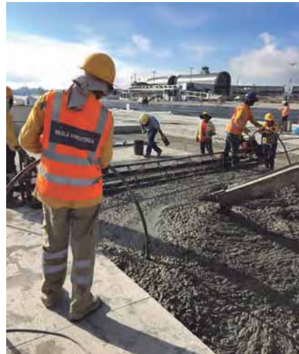
Figura 11.37. Compactación con vibrador de inmersión †
