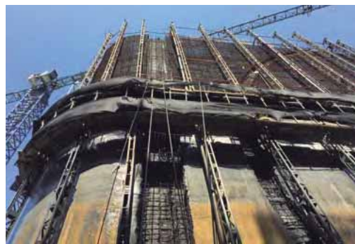
Figura 12.7. Curado de superficie vertical mediante riegos de agua †
