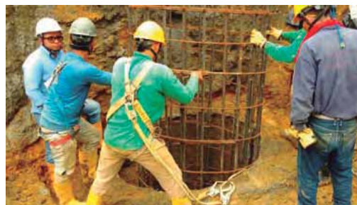
Figura 9.11. Colocación del refuerzo de un pilote a ser fundido con el sistema Tremie
