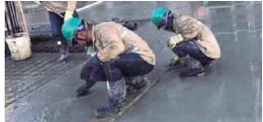
Figura 11.46. Alisado de piso con llana metálica †
