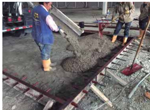
Figura 11.18. Descarga de concreto con mixer ✧
