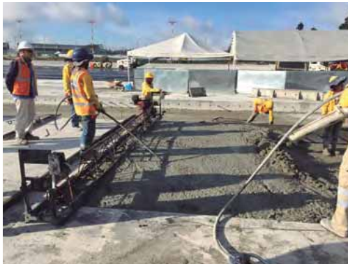
Figura 11.41. Regla vibratoria *
