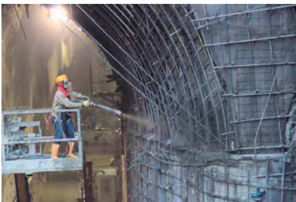
Figura 9.16. Aplicación del concreto lanzado Colocación de concreto lanzado en obra Hidroituango Cortesía Constructora Conconcreto-Coninsa-Camargo Correa
