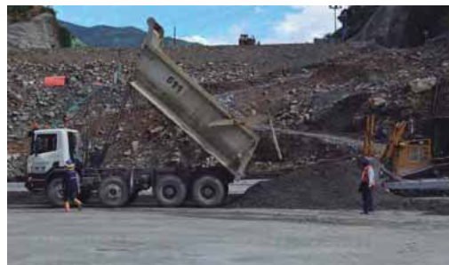
Figura 11.19. Volqueta para transporte de concreto
