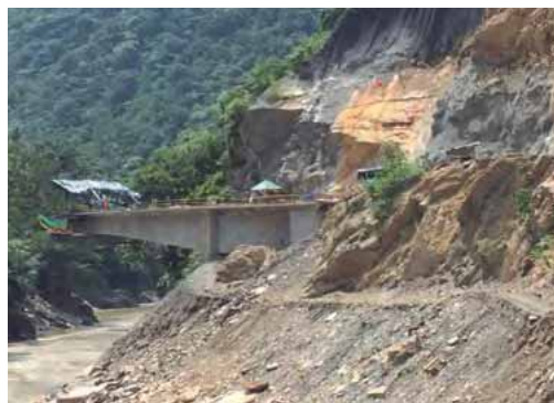
Figura 9.13. Colocación de concreto bombeado en punto de difícil acceso †
