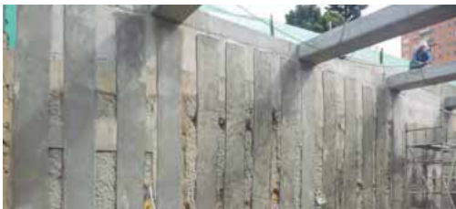
Figura 11.33. Preparación de la superficie: obtención del perfil de adherencia
