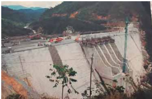
Figura 9.5. Aspecto y compactación del CCR con rodillo vibratorio Obra Porce II (Constructora Conconcreto-Coninsa y Camargo Correa)
