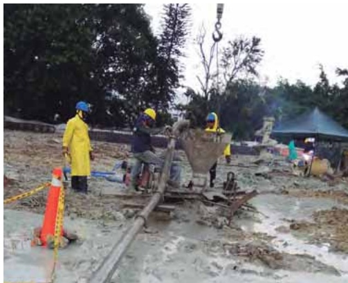
Figura 9.10. Foto de concreto Tremie Cortesía: Juan Diego Londoño
