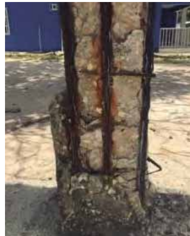
Figura 1.6. Ataque por sulfatos y cloruros †
