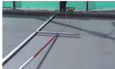
Figura 11.47. Cepillado del concreto †
