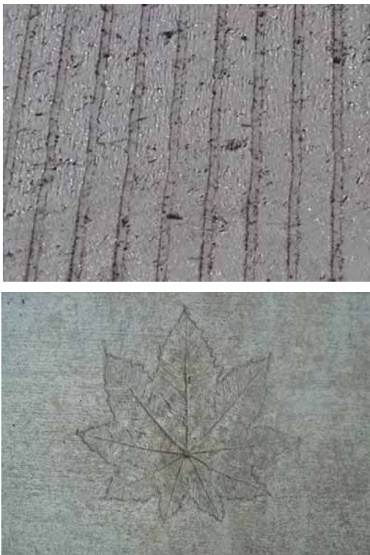
Figura 11.48. Algunas formas y texturas del concreto ❖
