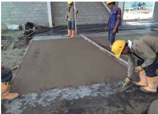
Figura 11.43. Enrasado del concreto mediante regla †
