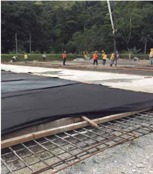
Figura 12.8. Curado con manta absorbente †
