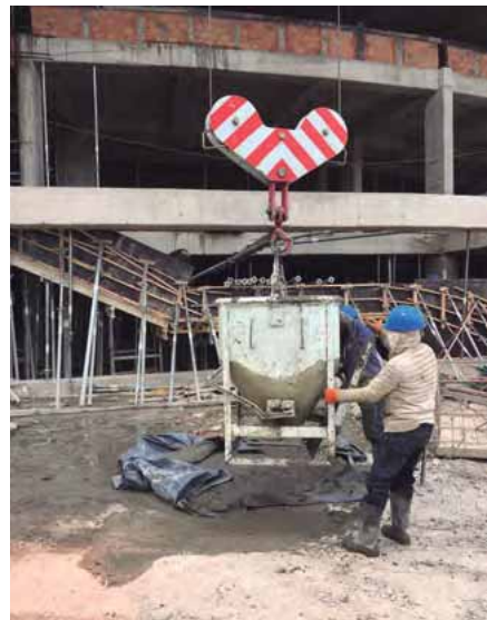
Figura 11.21. Sistema de balde y torre grúa para manejo, transporte y colocación de concreto †
