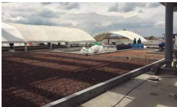
Figura 12.16. Barrera de sol sobre un pavimento de concreto realizado sobre un lleno con Livitek® (agregado termo expandido) †
