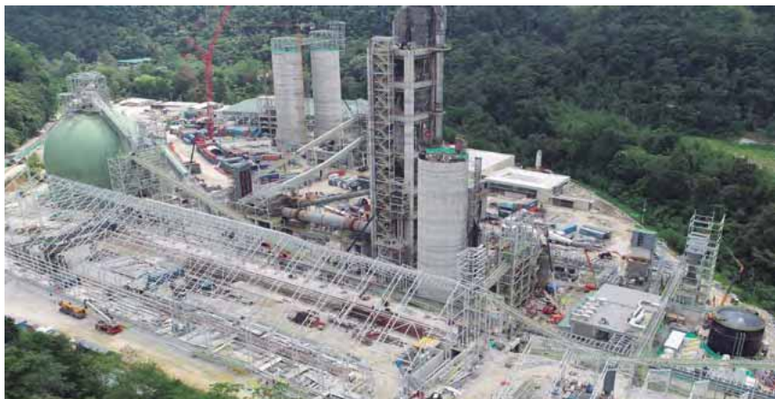
Figura 2.1. Construcción de una planta de cemento de última generación (Cortesía Empresa Colombiana de Cementos)
