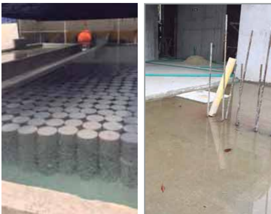
Figura 12.6. Curado † Izquierda: inmersión. Derecha: inundación
