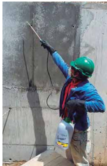
Figura 12.15. Aplicación de membrana de curado †
