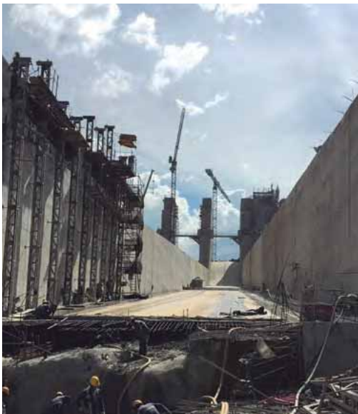
Figura 9.21. Fundida de estructuras con concretos masivos Vertedero- Proyecto hidroeléctrico Ituango- Colombia. Cortesía Constructora Conconcreto
