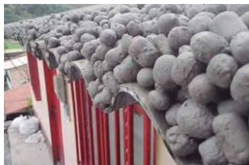
Figura 10.7. Ejemplo de un concreto liviano, sin finos, para protección térmica. Cortesía Constructora Conconcreto
