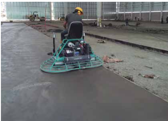
Figura 11.45. Emparejado del concreto mediante “helicóptero” †
