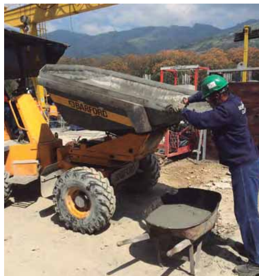
Figura 11.27. Transporte de concreto en buggy ✧
