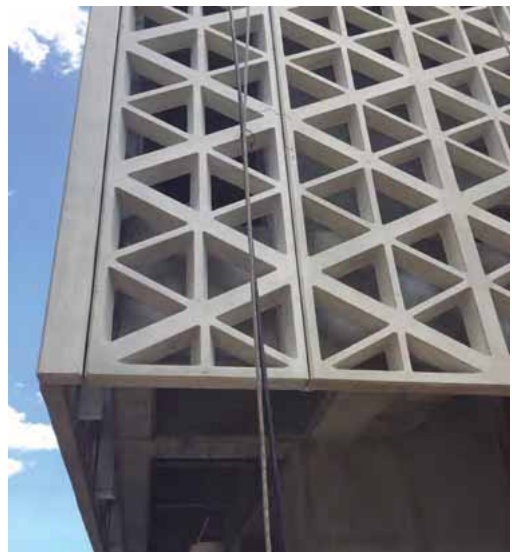
Figura 11.50. Concreto con pintura mineral Obra Edificio EDU-Constructora Conconcreto, Medellín *
