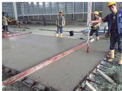
Figura 9.18. Construcción de un piso industrial usando concreto con contracción compensada †
