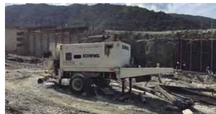
Figura 11.25. Bombas montadas en camión y en remolque*
