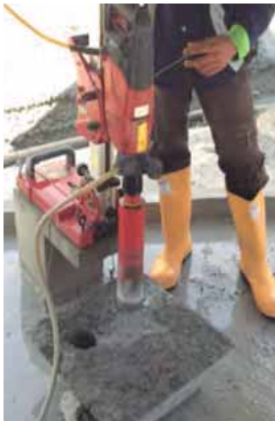
Figura 13.5. Toma de núcleos de concreto ✧
