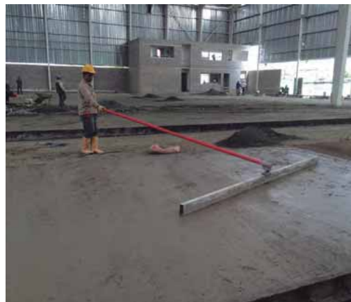
Figura 11.44. Aplanado del concreto con flotadora †
