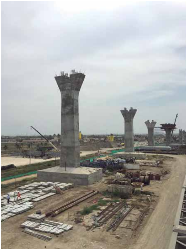
Figura 9.2. Proceso de construcción del puente Pumarejo. Durabilidad especificada mayor de 100 años ‡
