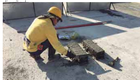
Figura 13.2. Elaboración de vigas de concreto para medir módulo de rotura §
