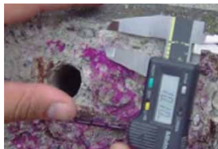
Figura 7.18. Medición de la carbonatación del concreto †
