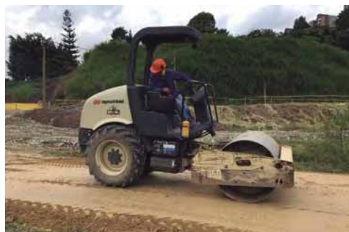
Figura 9.7. Rodillo vibratorio aplicado a suelo cemento
