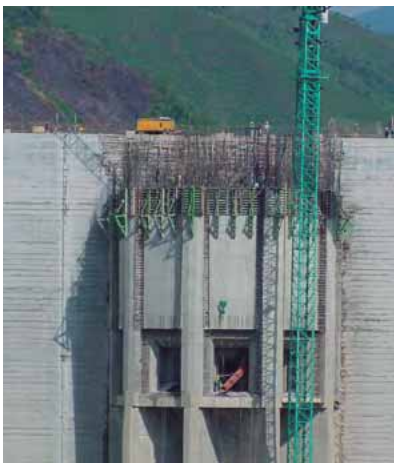
Figura 9.8. Presa de la central hidroeléctrica de Porce II
