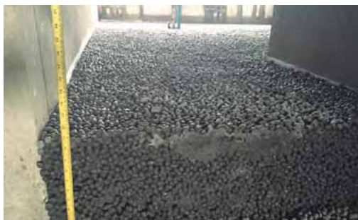
Figura 10.5. Ejemplo para una capa de nivelación en pisos con agregados livianos †
